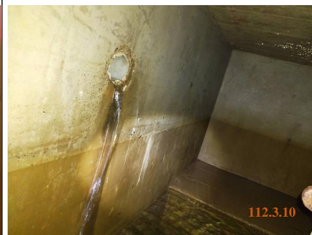
照片二 管道積水情形
