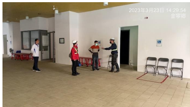
照片五 3月24日討論異常排水致管道積水(後續待總務處、體育室查異常排水)
