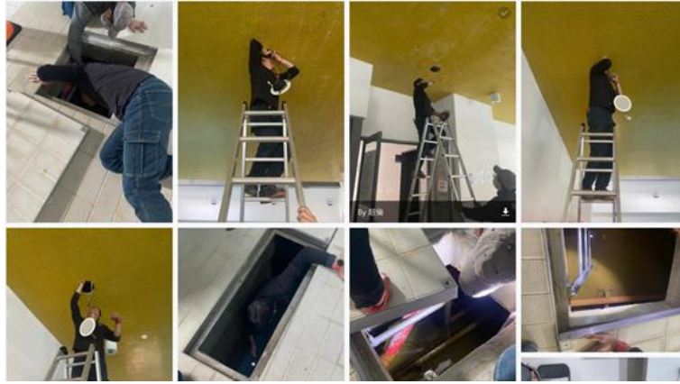
圓樓及學人宿舍消防設備改善照片1
