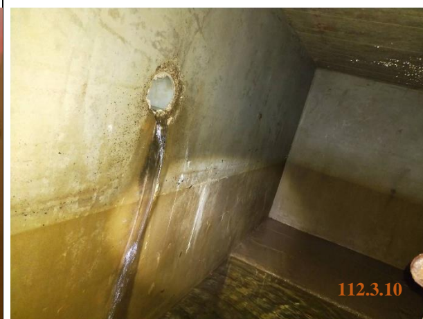
照片二 管道積水情形
