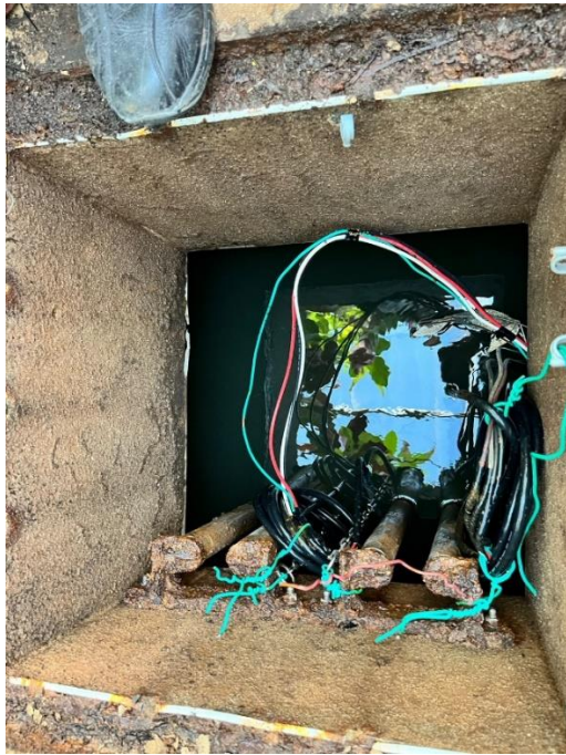
更換泵浦線路及兩台泵浦入水位置
