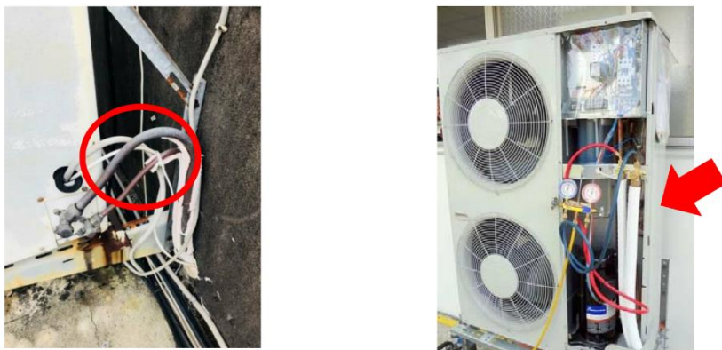
圖 6、冰水管路應妥善包裹適當材料之保溫棉以維持冷房效果
