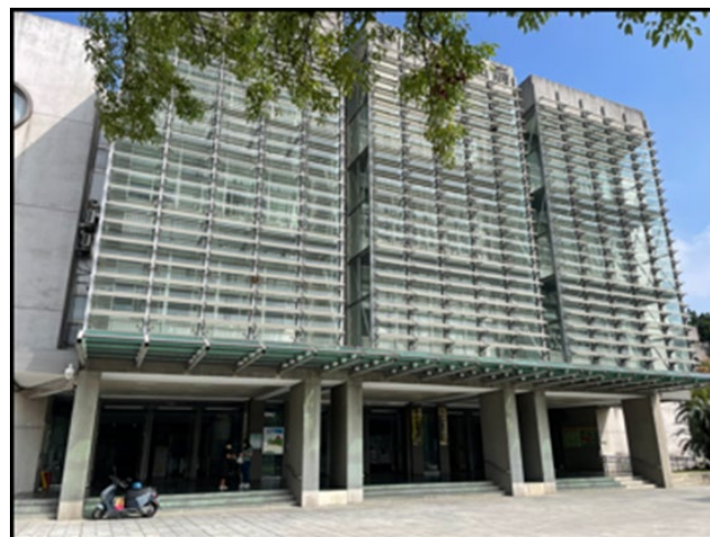
圖 3 建築整合型太陽光電設施
